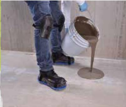
Mortero reforzado fluido para nivelar pisos.
